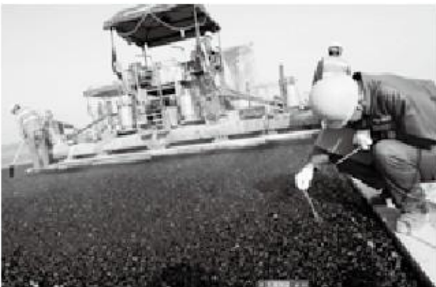
济莱高速大粒径透水性沥青混合料施工现场
